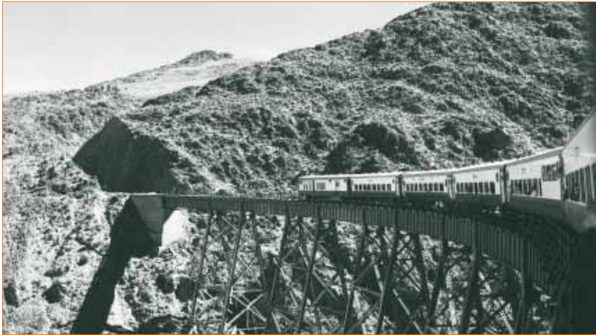
El Tren a Las Nubes, Argentina, monumental obra de ingeniería y atracción turística internacional.
