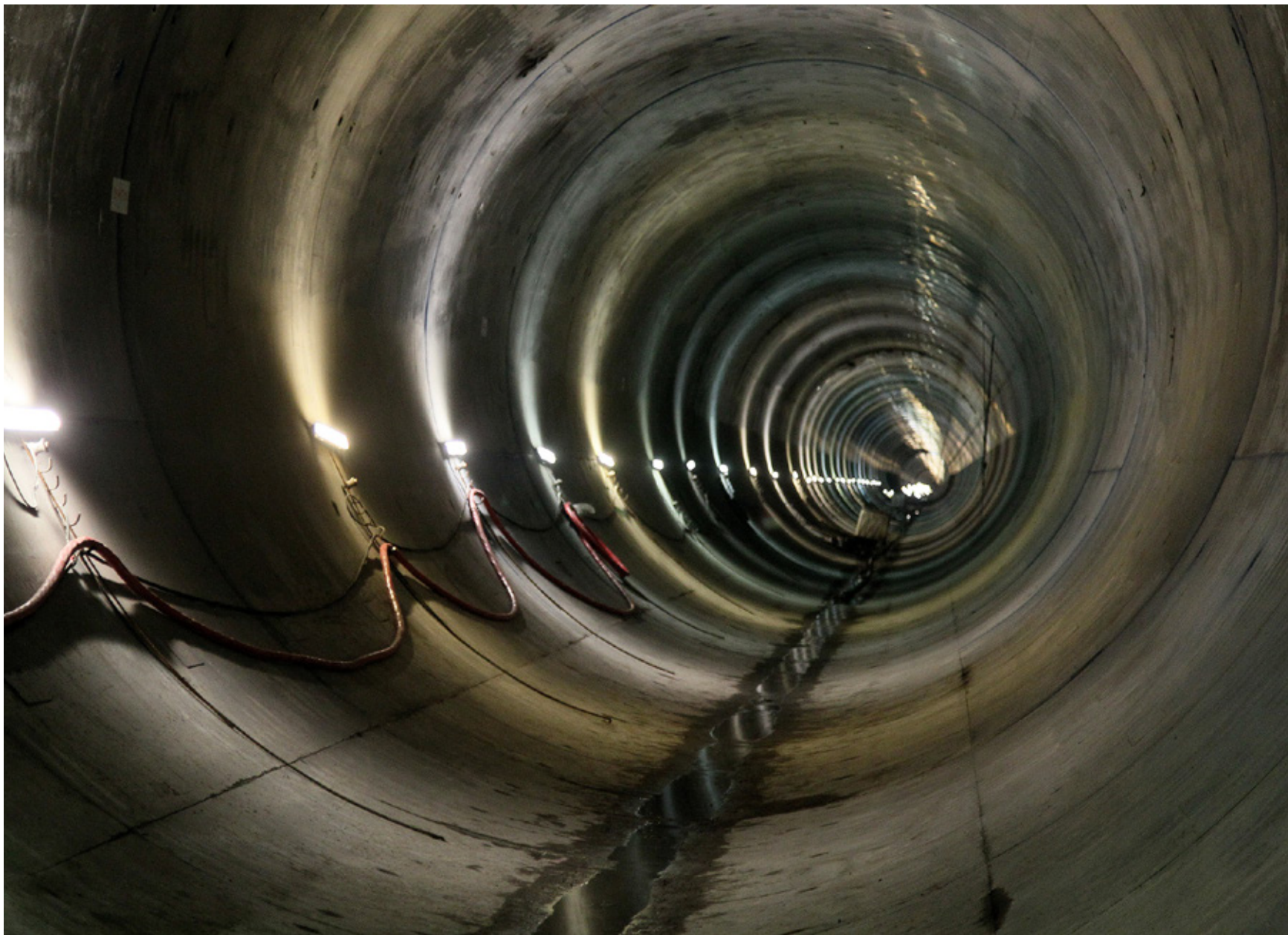
Tunel Emisor Oriente Fotografía: Notimex
