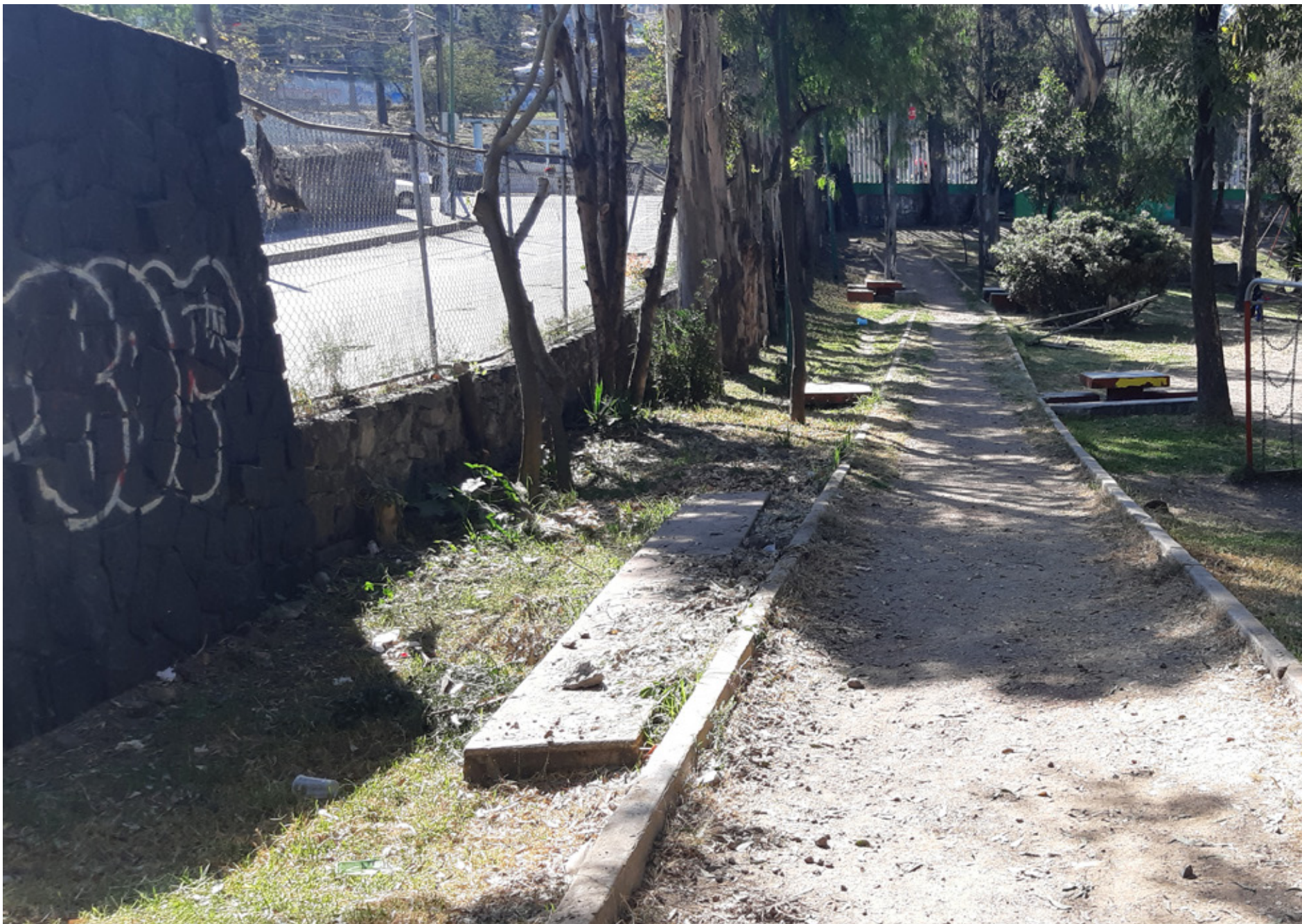
¿Banca hundida o rellenada? Posible indicio de hundimientos dentro del Deportivo San Gregorio Atlapulco
