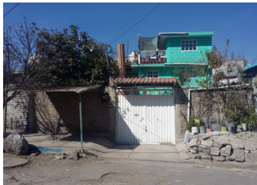
Vivienda ubicada sobre la calle Francisco Villa (muros de block gris con pintura)
