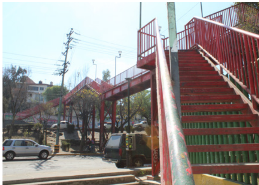
Puente peatonal cercano al Deportivo San Gregorio Atlapulco Fotografía: Taller Capital
