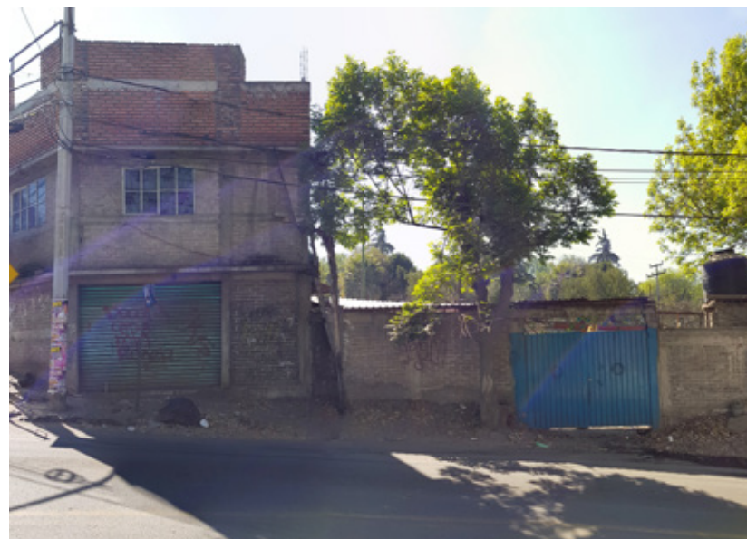
Vivienda ubicada sobre Av. Nuevo León (muros de block gris y ladrillo rojo)
