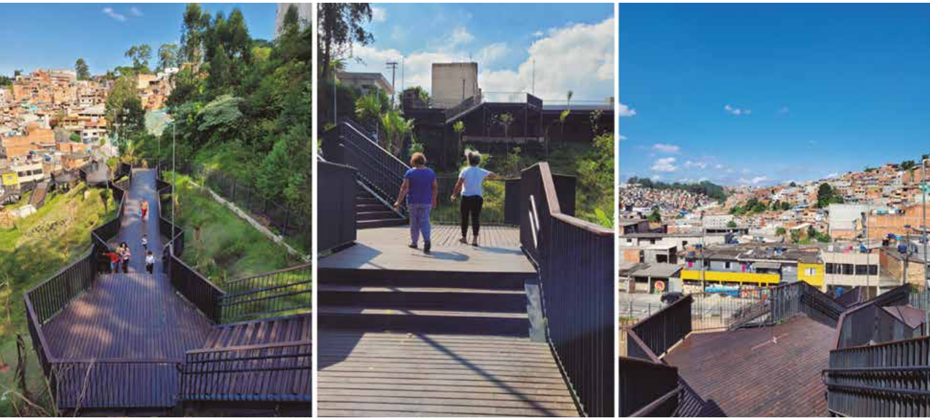
Figura 1: Fotos de escaleras Parque Urbano Mata Virgem (2023).
