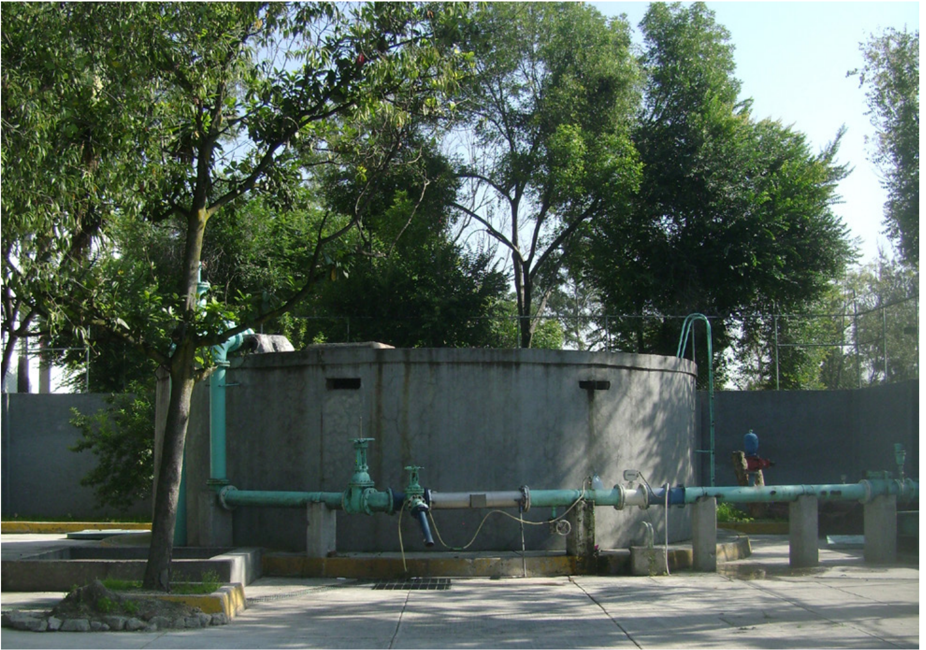
Pozo de extracción en Álvaro Obregón
