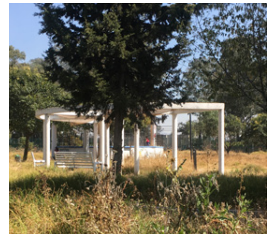
Estructura de concreto con acabado de pintura Fotografía: Taller Capital
