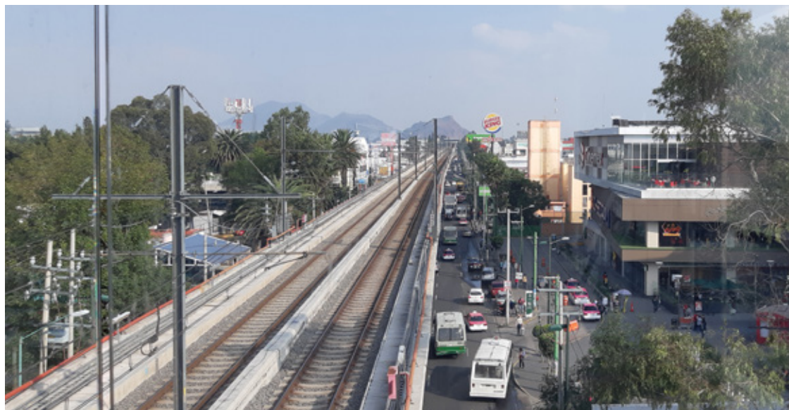
Línea 12 del metro sobre avenida Tláhuac
