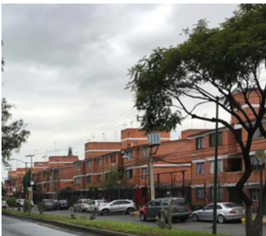
Forma de conjunto habitacional C
