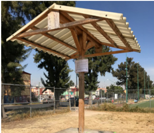
Cubierta de lámina de asbesto con estructura de madera Fotografía: Taller Capital
