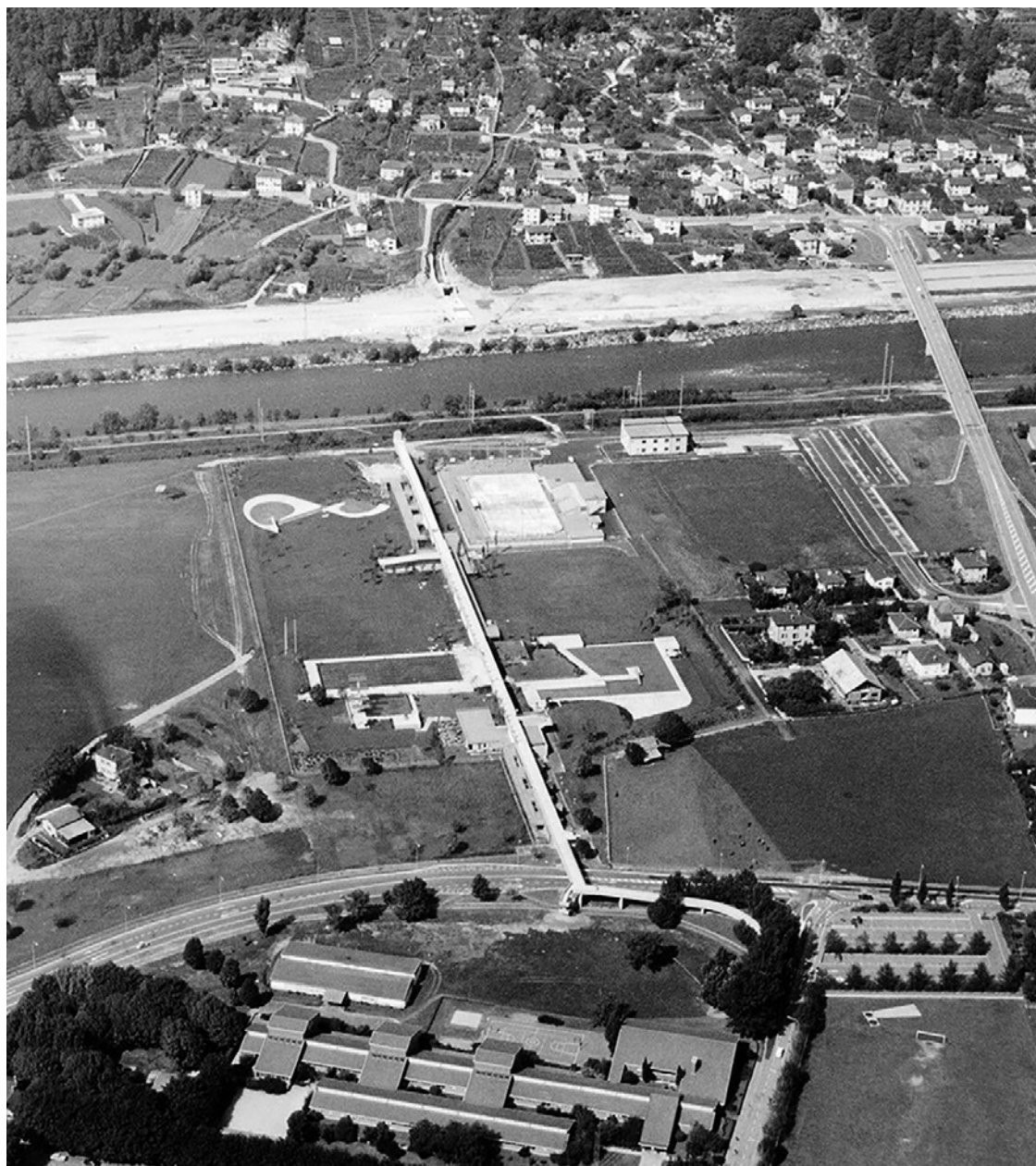
Piscina de Bellinzona, vista aérea
