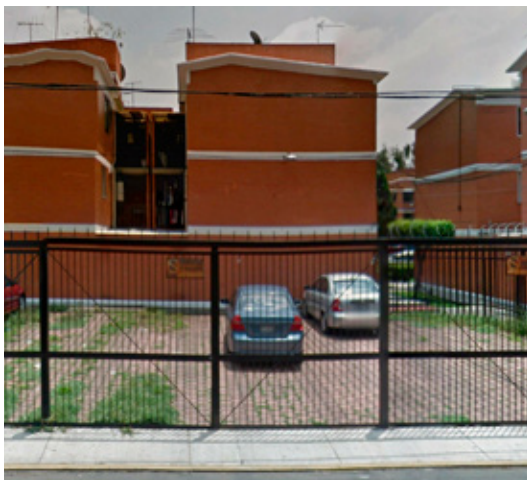
Acceso a predio de conjunto habitacional C Fotografía: Taller Capital
