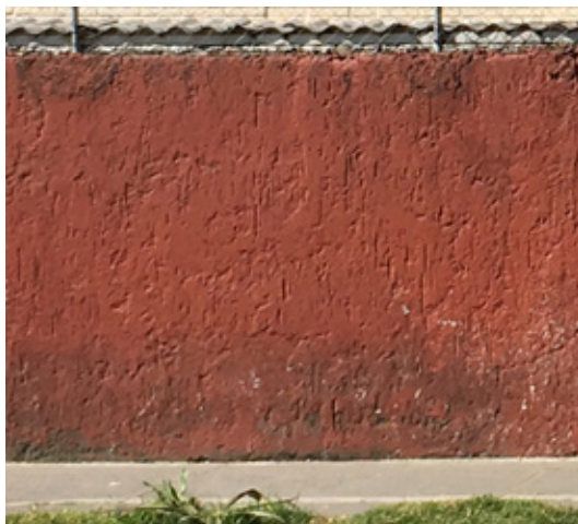
Muro ciego de conjunto habitacional A
