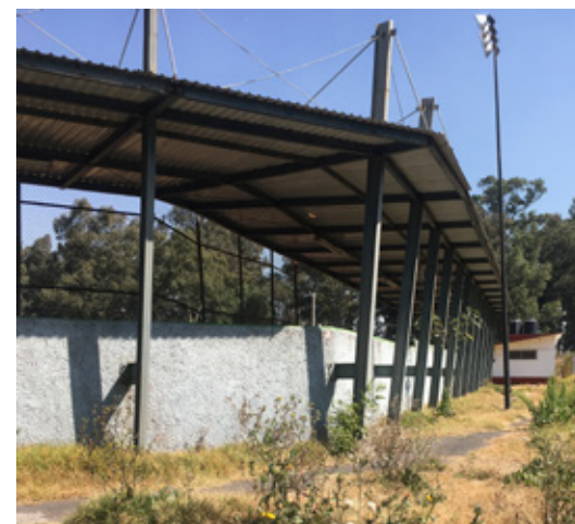
Cubierta de lámina galvanizada y estructura de acero
