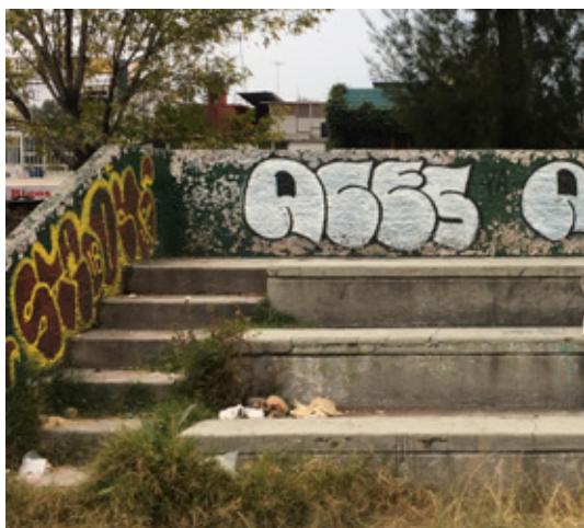
Gradas de concreto con acabado de aplanado
