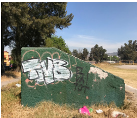
Muro de concreto con acabado de aplanado y pintura
