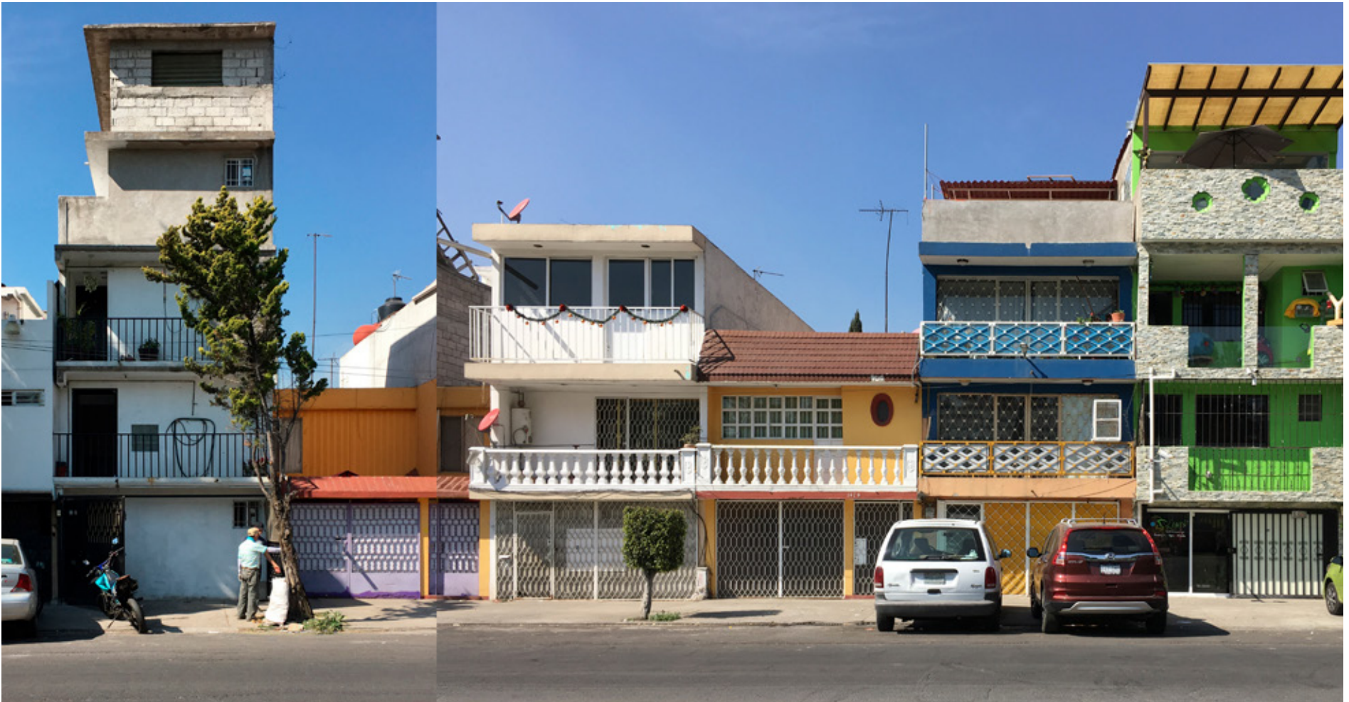
Autoconstrucción en la vivienda unifamiliar
