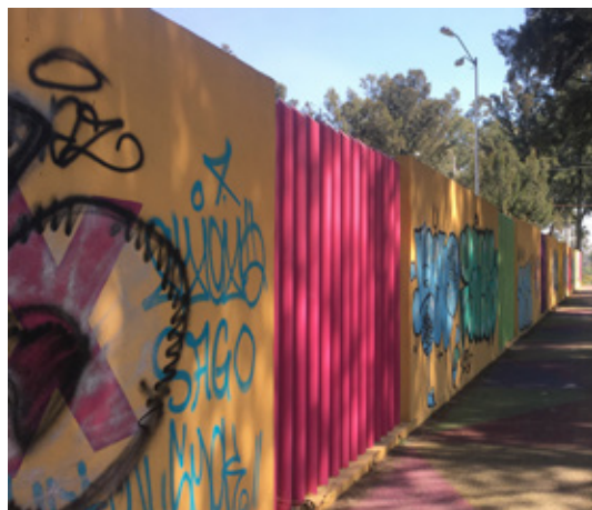
Reja tubular y muro de concreto con acabado de pintura
