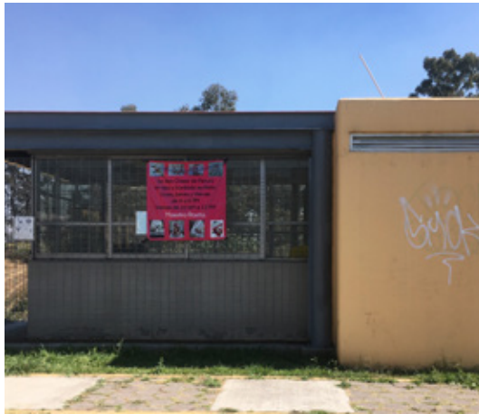
Módulo de concreto con aplanado y estructura de acero Fotografía: Taller Capital
