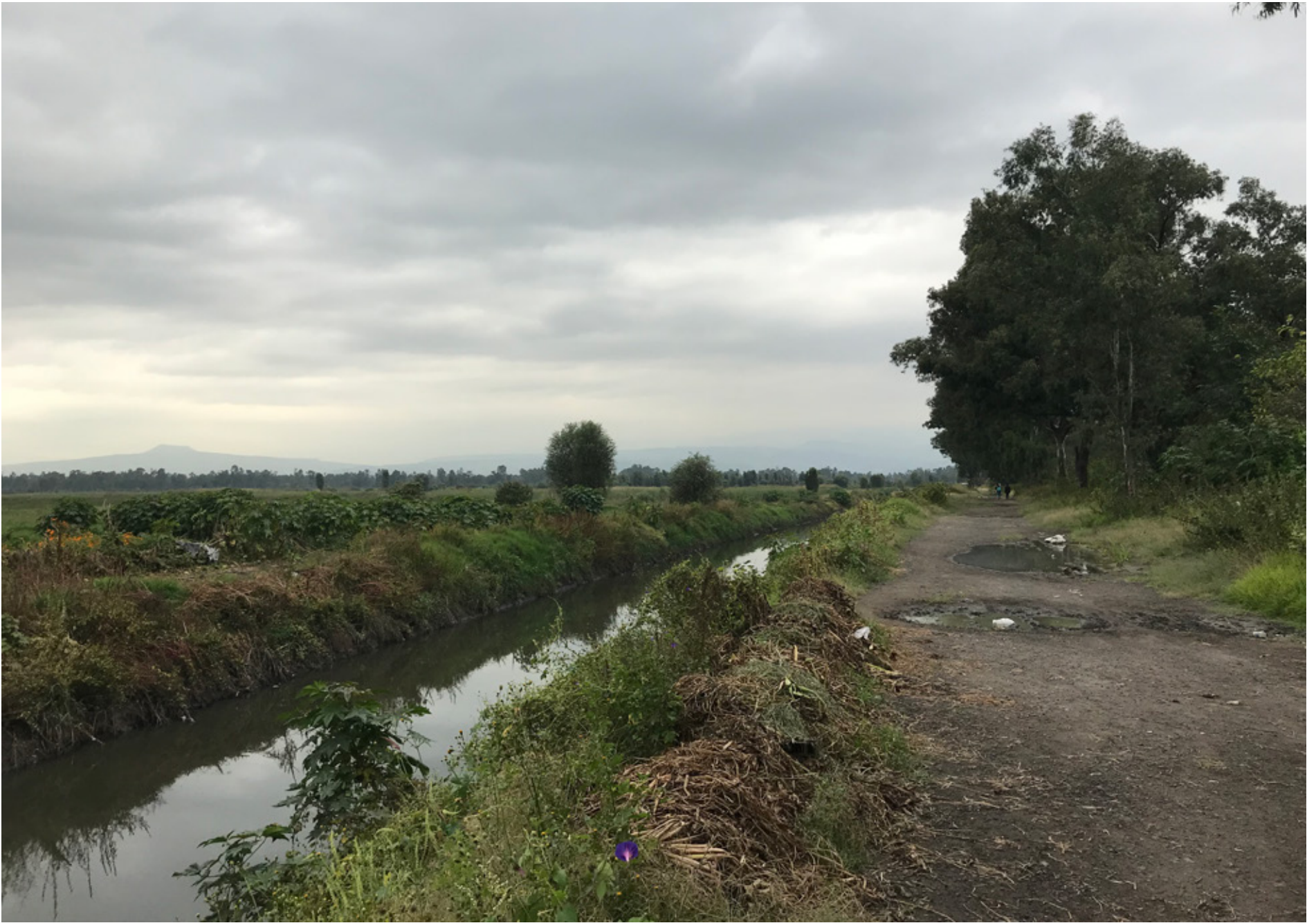
Canal de desagüe de agua residual paralelo a Canal Nacional, Ciénega Grande, Xochimilco
