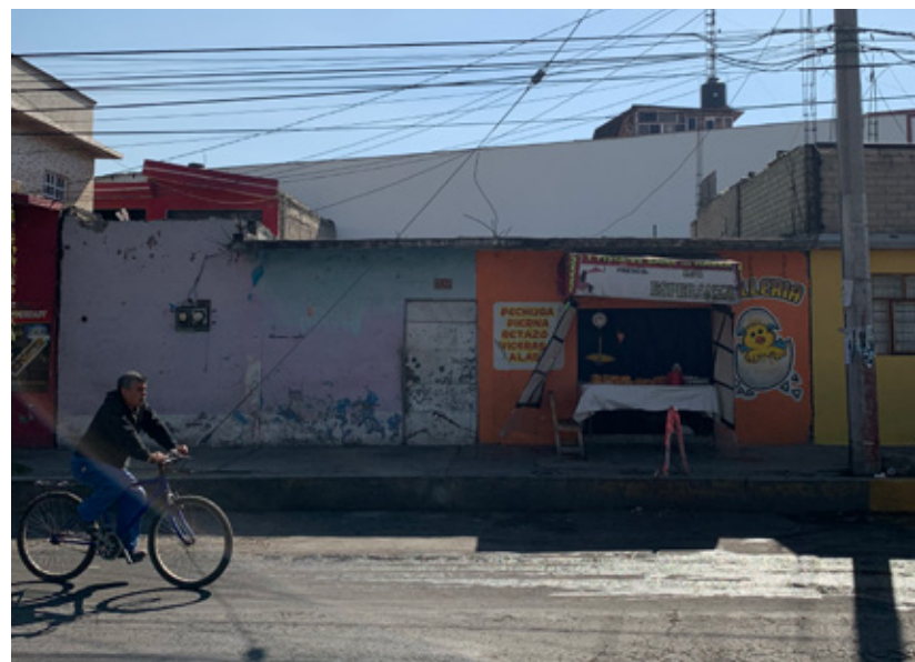
Fachada comercial con aplanado y pintura
