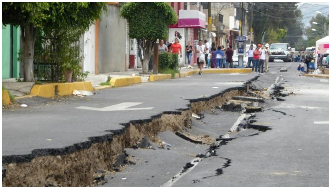
Grieta en la Colonia del Mar, Tláhuac, Ciudad de México
