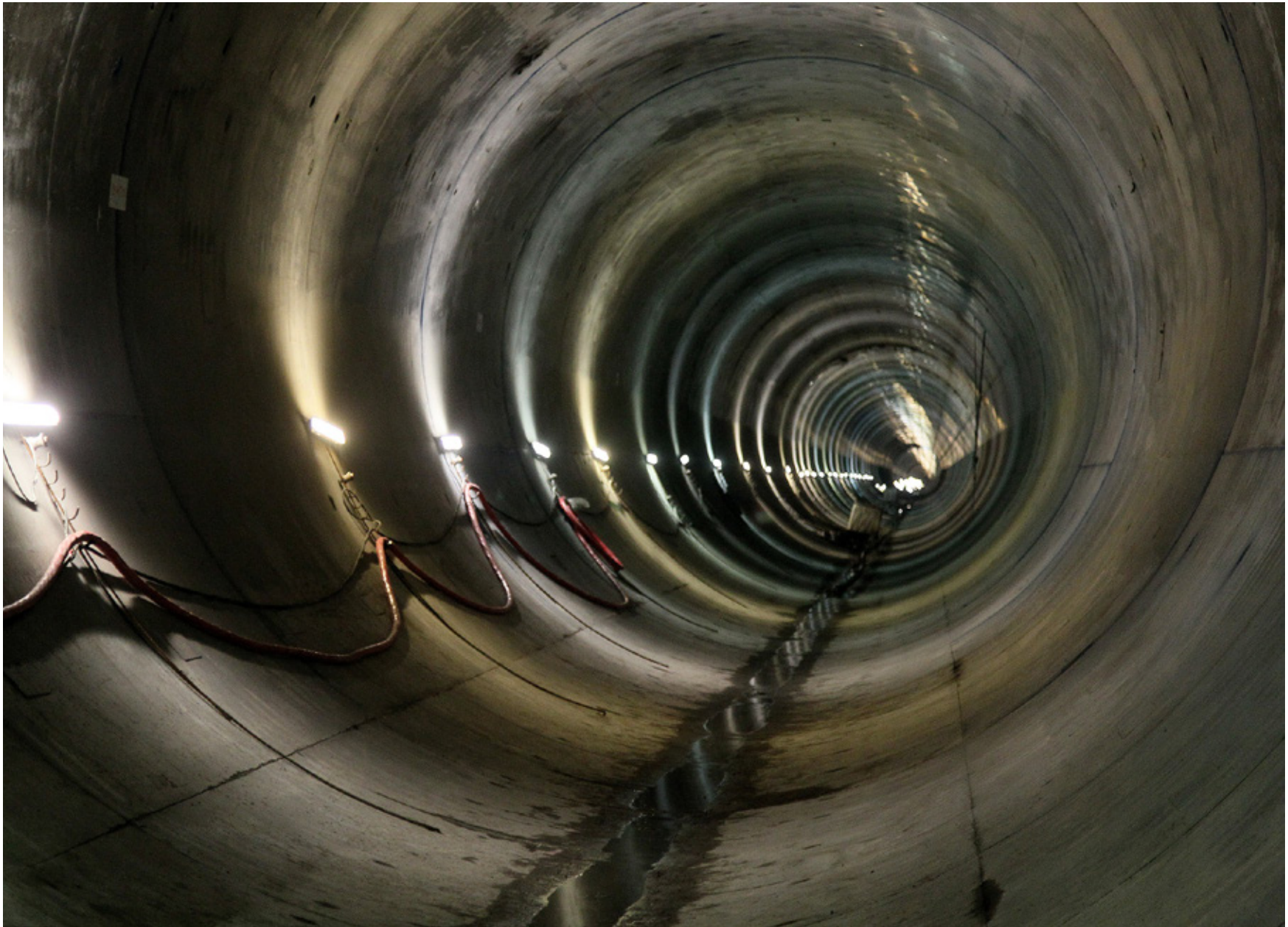
Tunel Emisor Oriente Fotografía: Notimex
