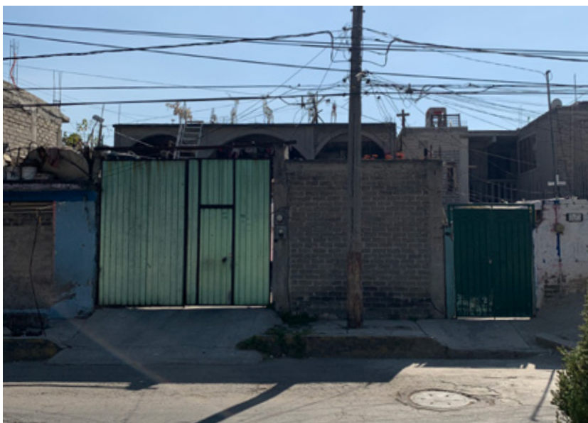
Muro de tabique de concreto con zaguán de herrería
