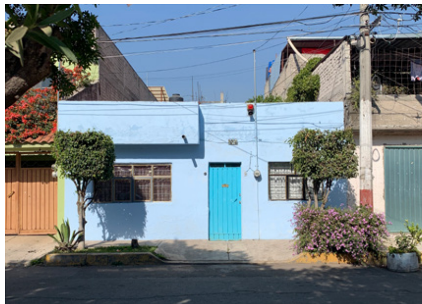
Muro de block con acabado de aplanado y pintura
