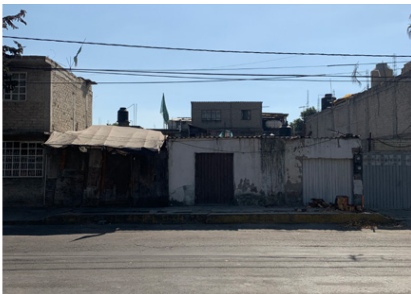
Muro de block con techo de lámina galvanizada
