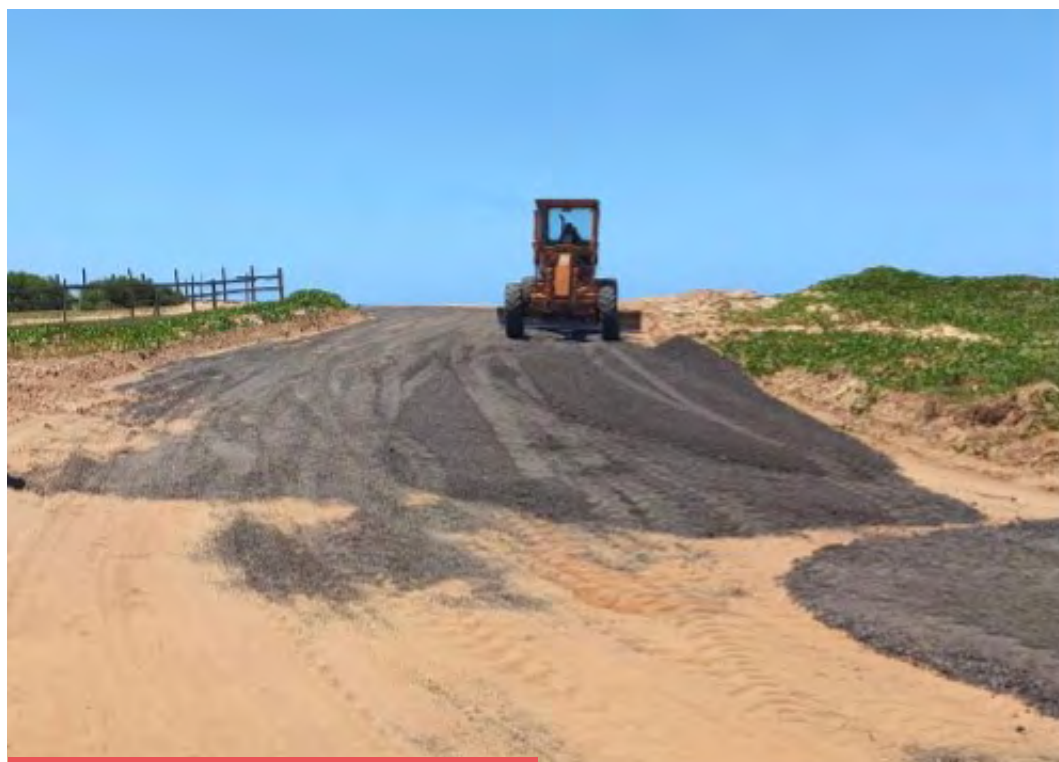
Figura 38. Recubrimiento con freado. Campos (RJ)
