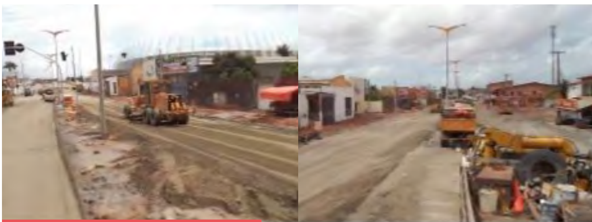
Figura 33. Ejecución de obra
