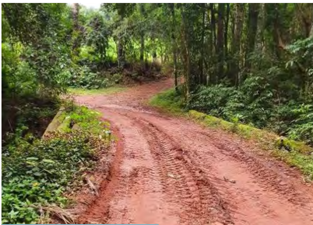
Figura 8. Sección transversal sin peralte
