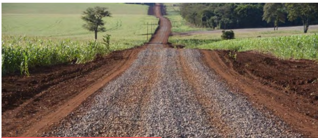
Figura 25. Revestimiento de piedra partida
