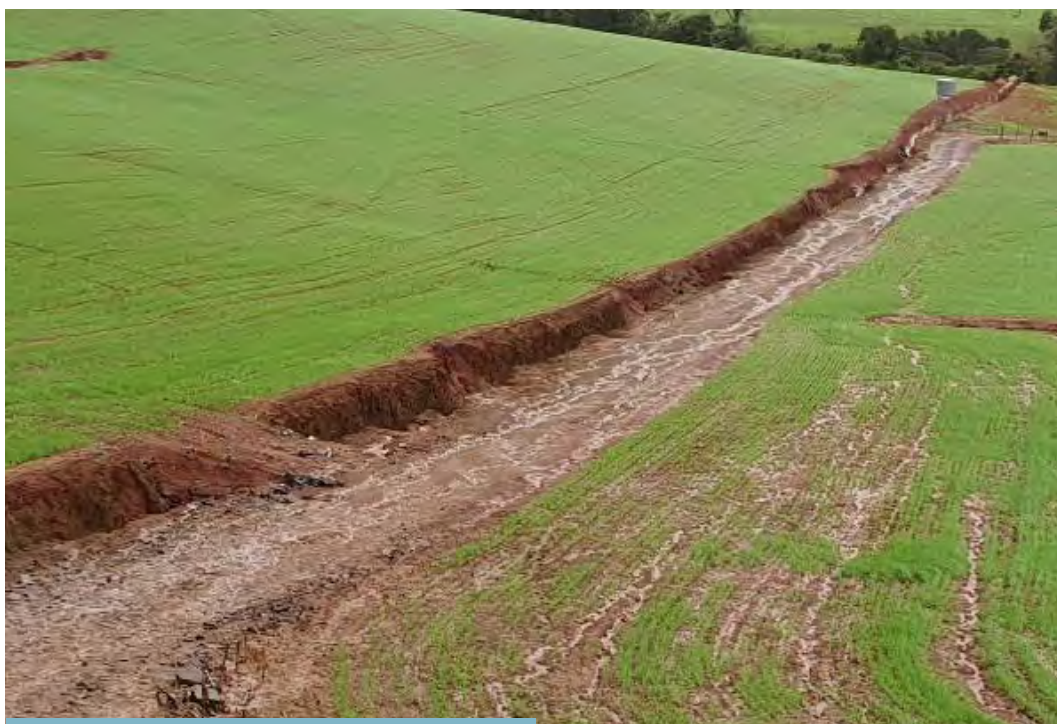
Figura 10. Drenaje inadecuado
