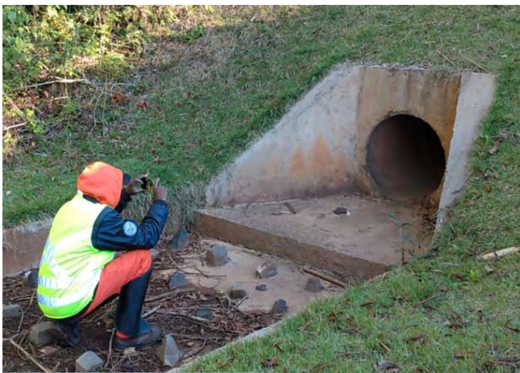
Figura 23. Inspección de drenaje
