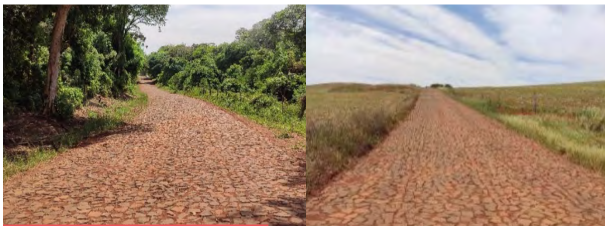
Figura 26. Revestimiento con piedras irregulares
