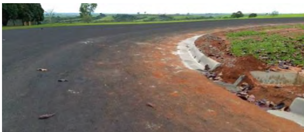
Figura 18. Sistema de drenaje superficial adecuado
