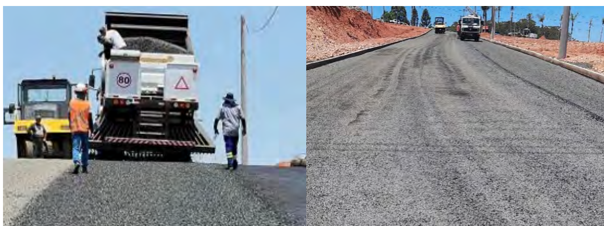
Figura 42. Ejecución de TSD con multidistribuidor
