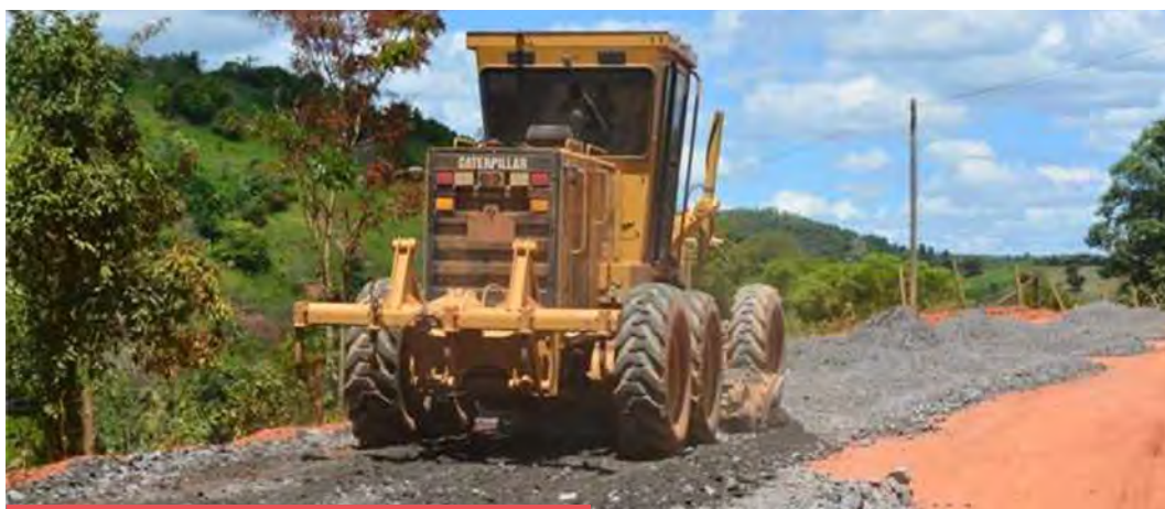
Figura 35. Revestimiento primario en acero. Alpercata - MG
