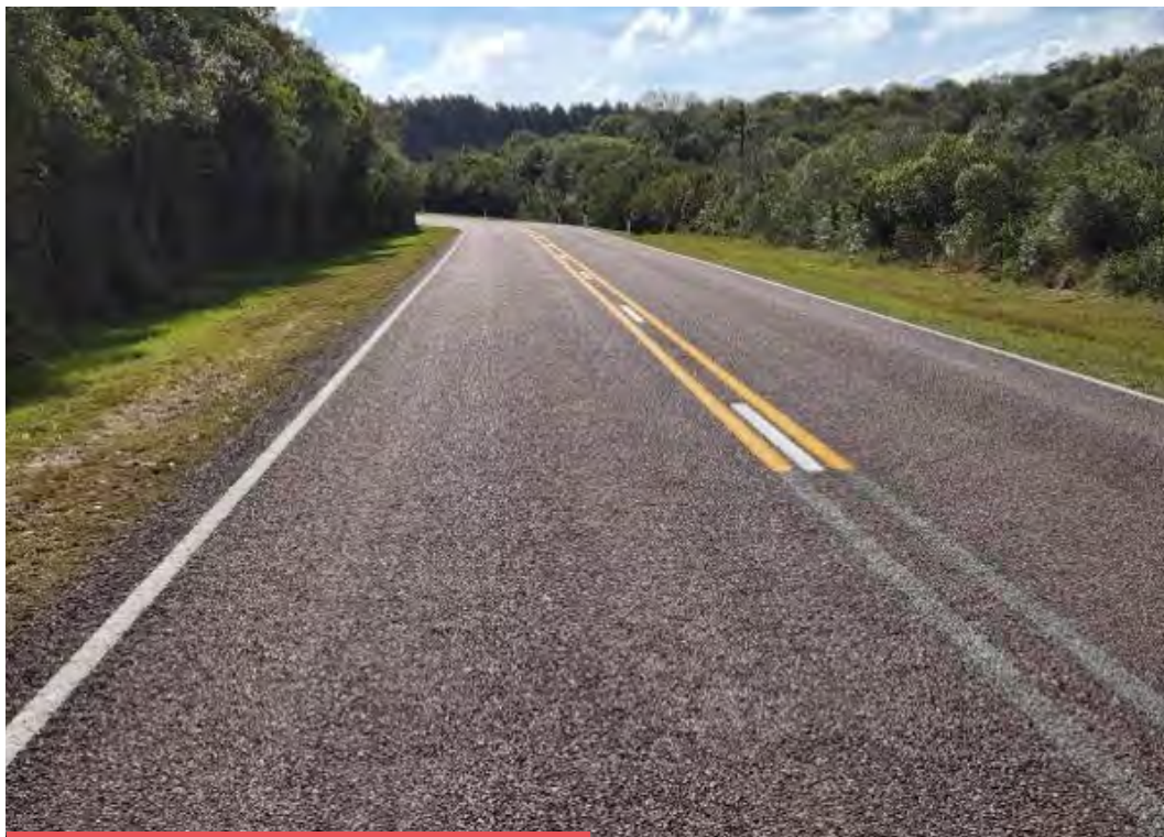
Figura 43. Pavimento en TSD Ruta 39 (Maldonado, Uruguay)
