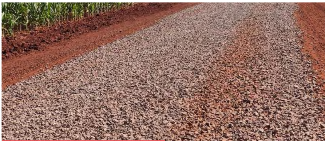
Figura 24. Revestimiento primario con piedra triturada
