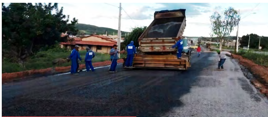
Figura 41. Ejecución de TSD en São Desidério (Bahia)
