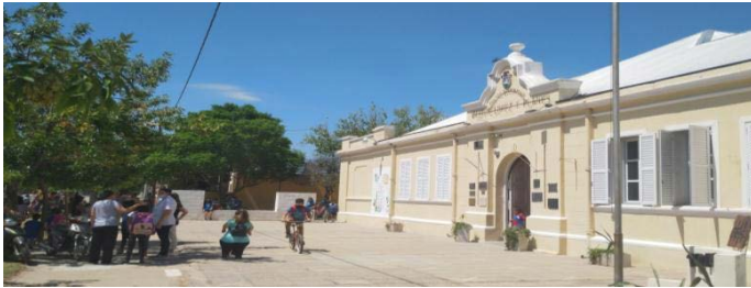
Foto: Infraestructura actual que se va a sustituir
