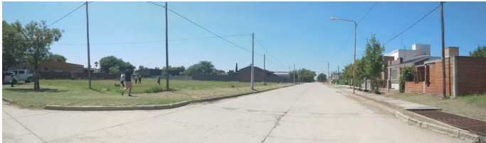
Foto: Solar para la nueva construcción
