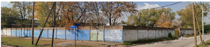
Foto: Fachada de la Escuela Primaria 97 sobre la calle Avelino Díaz y la calle W. J. Molins donde se construirá la Escuela Secundaria 87
