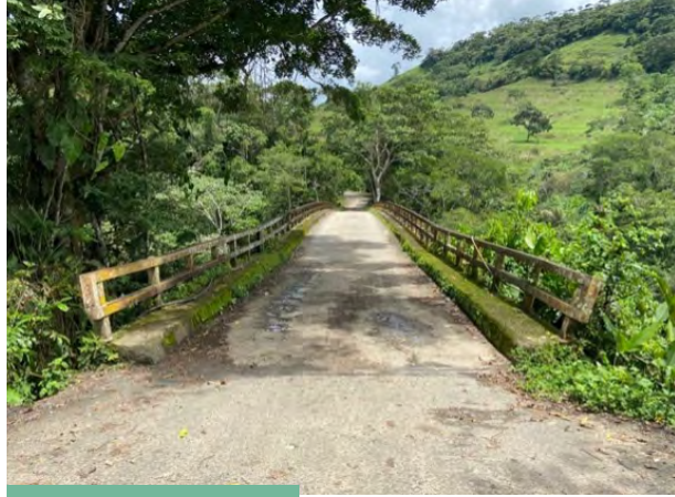
D. Puente en concreto
