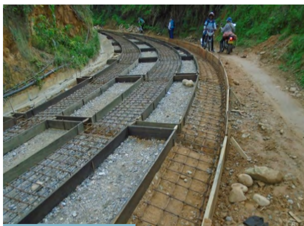
A. Placa huella en proceso constructivo
