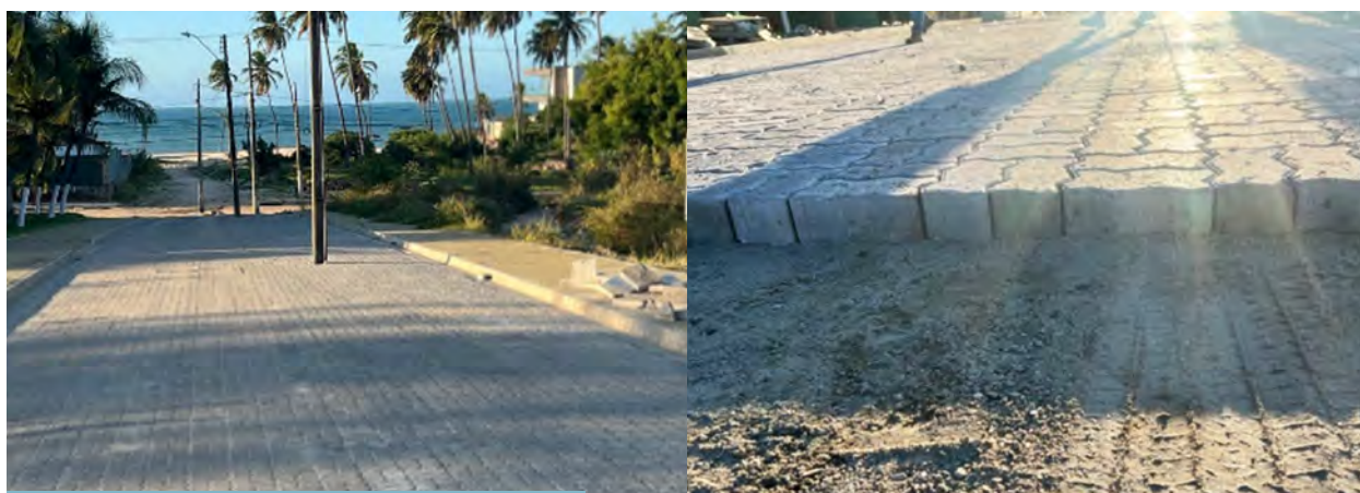
A. Pavimentos de adoquines de hormigón en Caucaia (Brasil)
