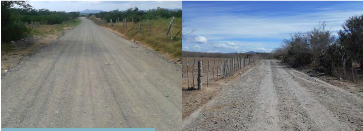
C. Formación de capa estabilizada con óxido de calcio (izquierda) y aspecto físico de la capa 3 años después (derecha) en el municipio de Tomatlán, en el Estado de Jalisco (México)
