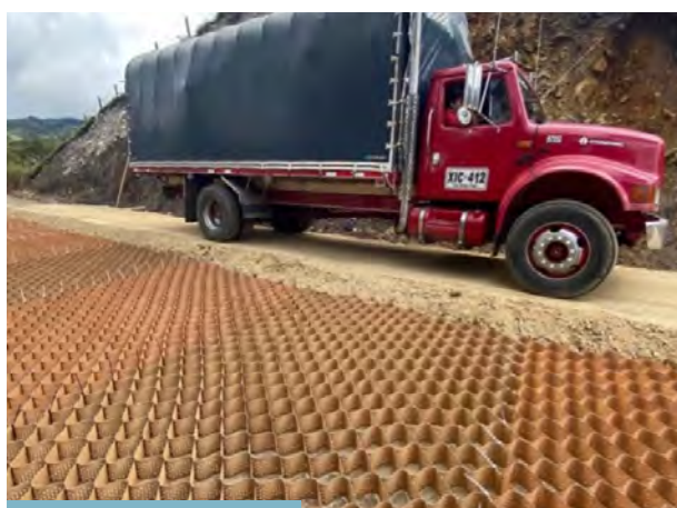
A. Geocelda rellena de material granular en carretera de Colombia
