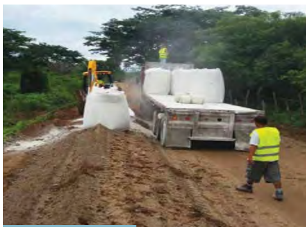
A. Material escarificado y encamado para la dosificación de óxido de calcio
