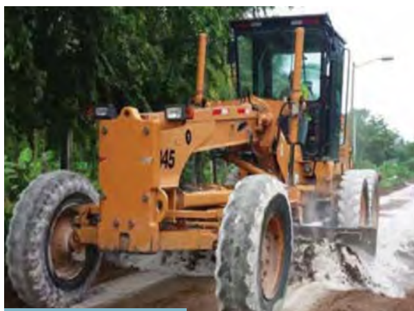
B. Homogeneización de arcilla con óxido de calcio
