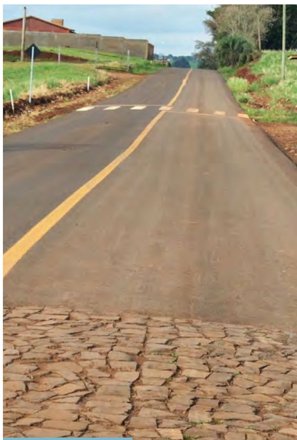
A. Restauración sobre empedrado
