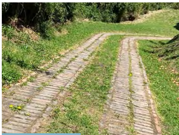
B. Huella en ladrillo camino del Municipio de Tabio (Colombia)
