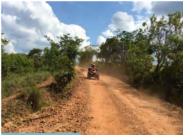
A. Camino en material granular de fuente local en Colombia
