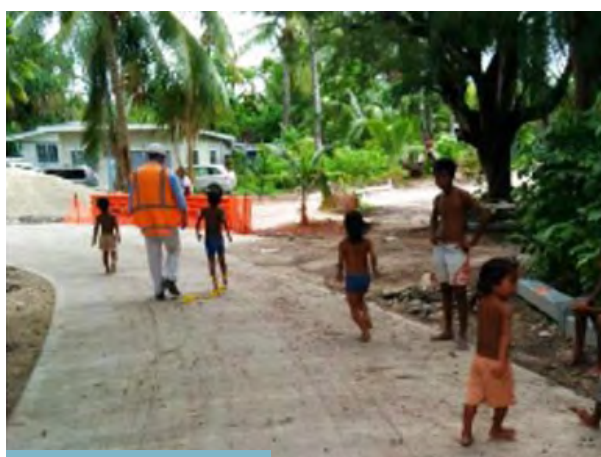
B. Sección de un camino rural después de ser tratado con geoceldas rellenas de hormigón en Kiribati
