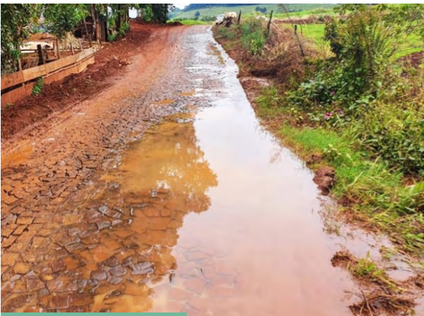
C. Camino en piedra con acumulación de agua por deficiencias del drenaje (Brasil)
