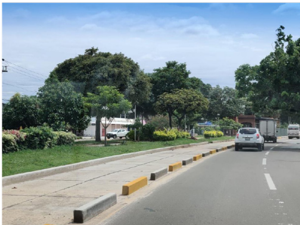
Figura 9. Plataforma de BRT sobre el Primer Anillo en construcción, Santa Cruz de la Sierra, Bolivia
