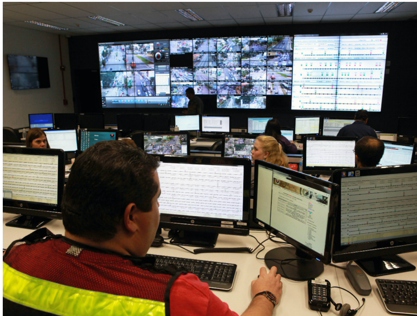
Figura 5-31. Centro de control operacional del sistema de transporte público colectivo de Curitiba, en Brasil.
