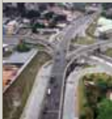
Viaduto Antônio de Andrade Simões, parte do Programa de Infraestrutura Urbana e Ambiental do Município de Manaus.
