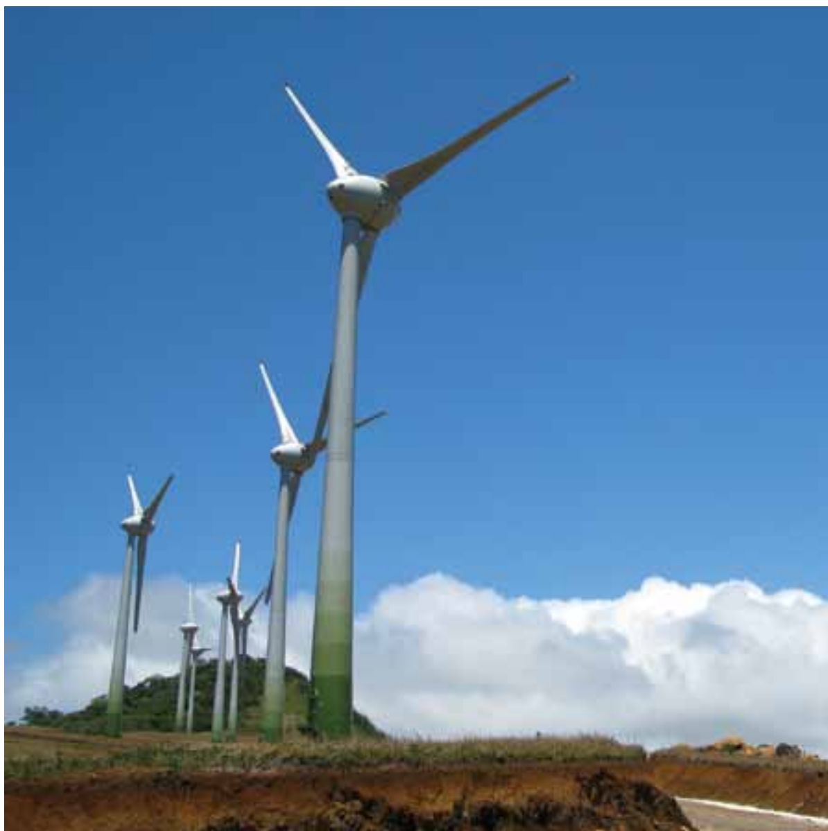
Projeto de Energia Eólica. Jamaica.
