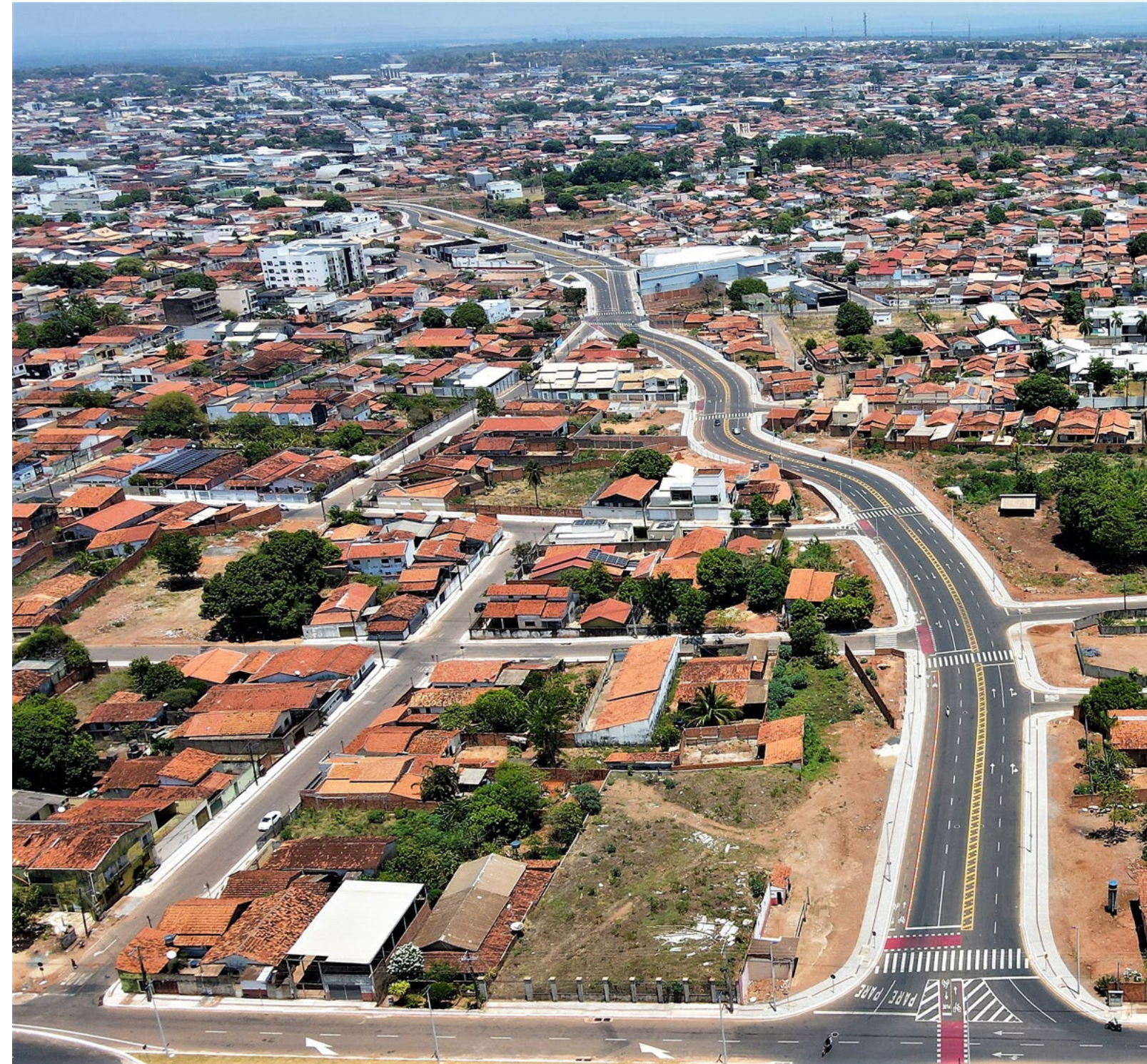
Primera etapa de la Avenida Via Norte, con 1,5 km de longitud, en Araguaína, Brasil.
