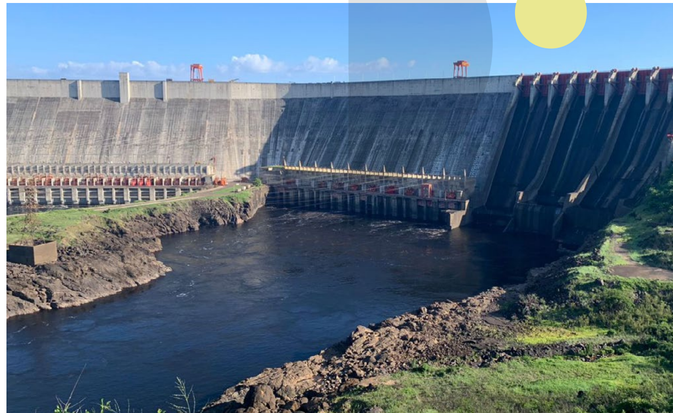
Central Hidroeléctrica Simón Bolívar, Estado Bolívar, Venezuela.
