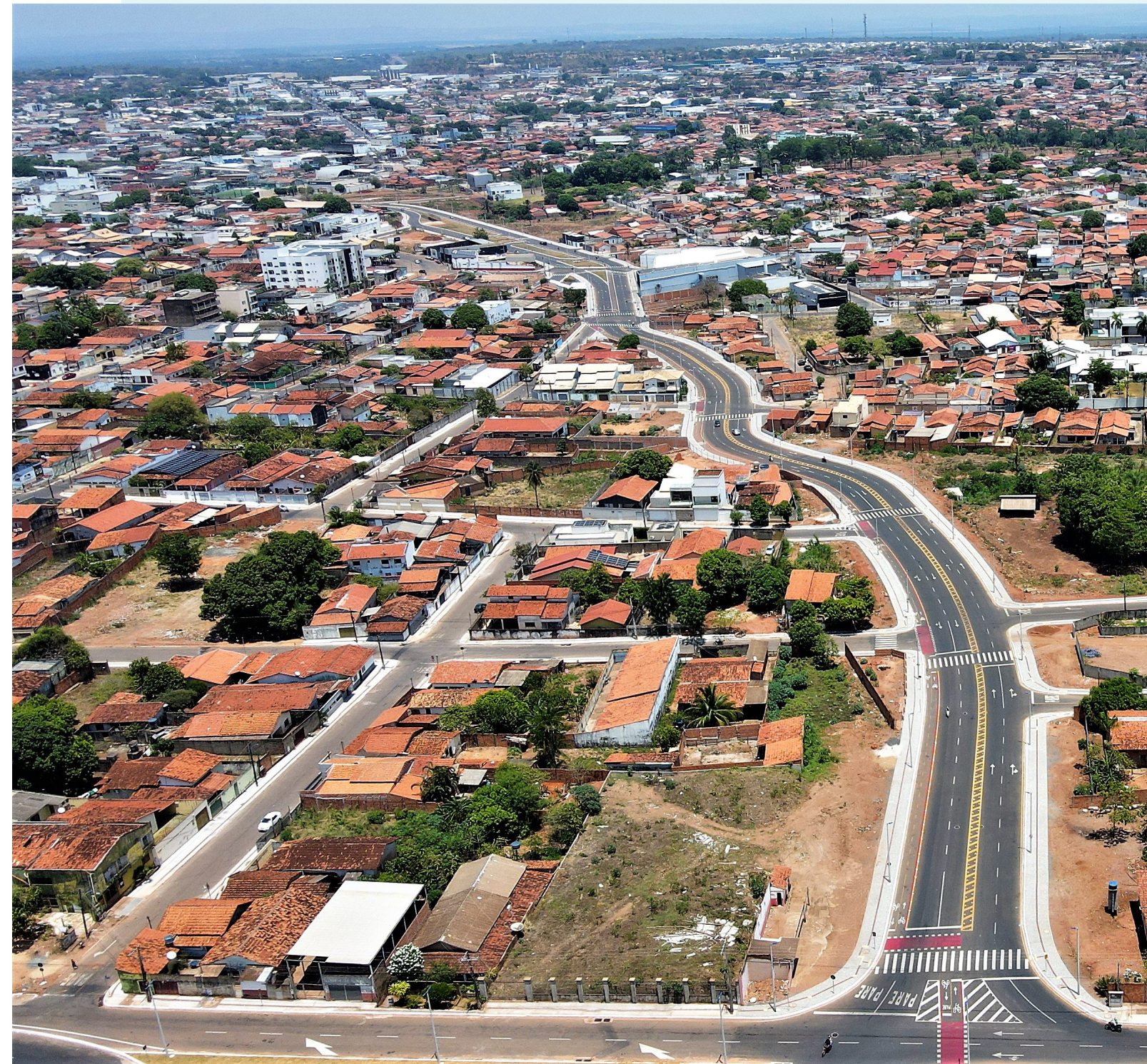
Primera etapa de la Avenida Via Norte, con 1,5 km de longitud, en Araguaína, Brasil.
