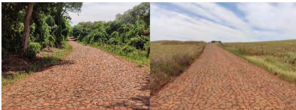
Figura 26. Revestimento com pedras irregulares
