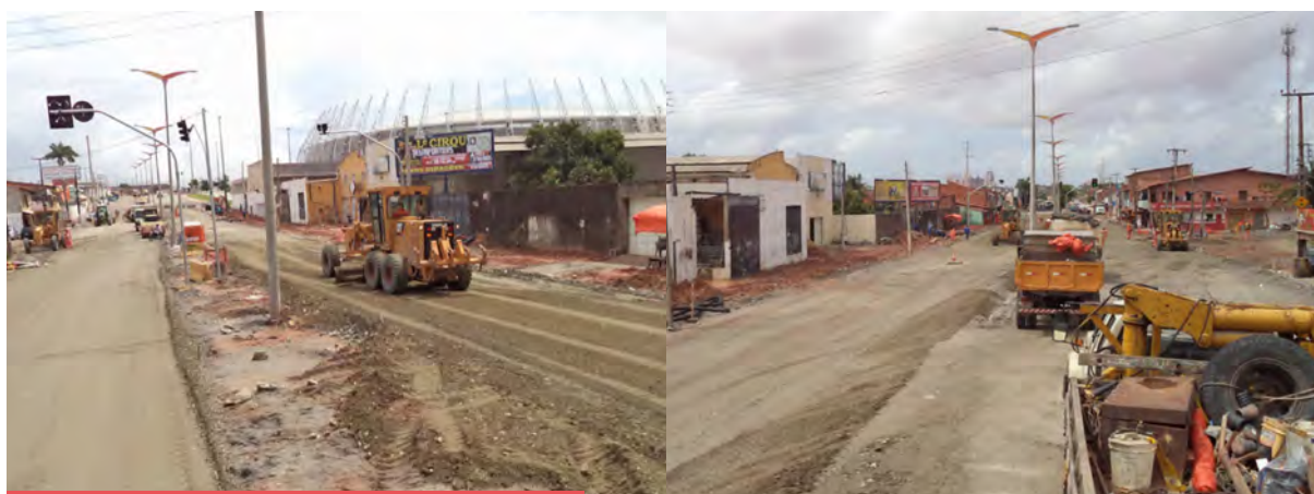
Figura 33. Execução do trabalho
