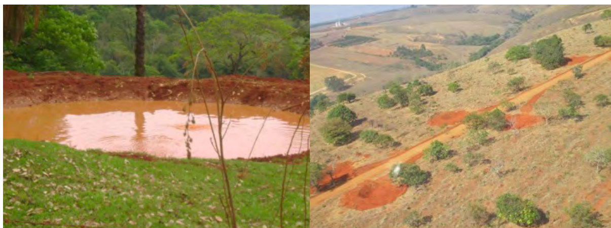
Figura 22. Bacias de captação ou “barraginhas”
