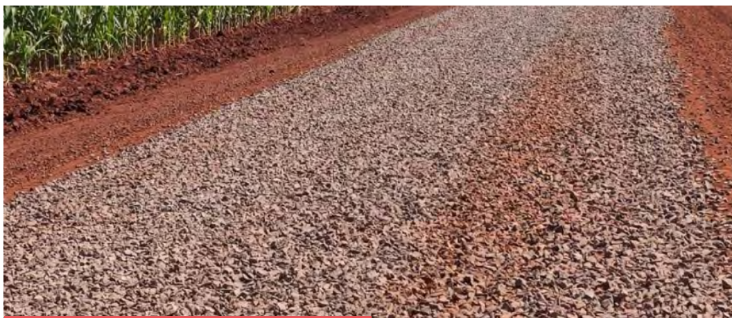
Figura 24. Revestimento primário com solo brita
