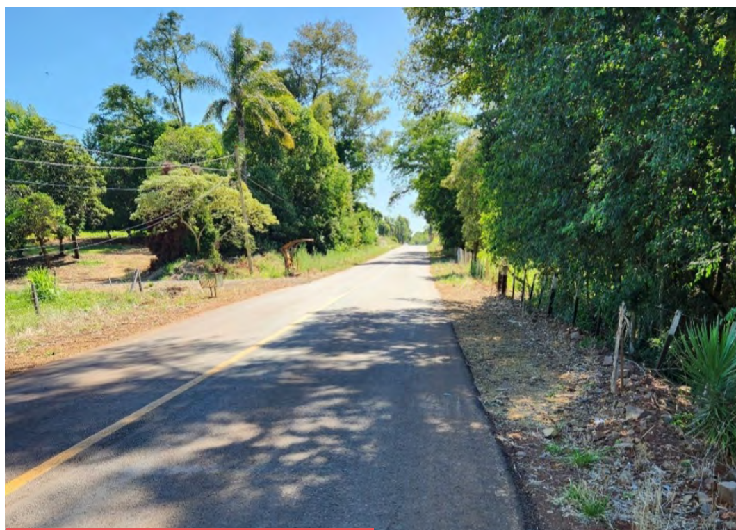
Figura 29. Camada asfáltica sobre pedras
