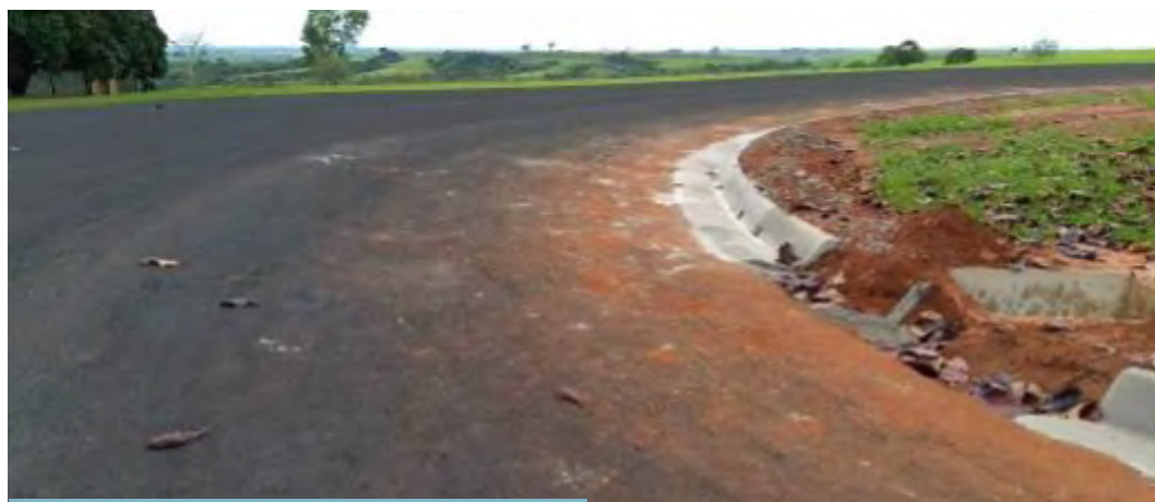
Figura 18. Sistema de drenagem superficial adequado
