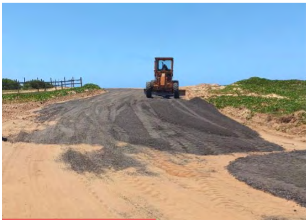
Figura 38. Revestimento com fresado. Campos (RJ)
