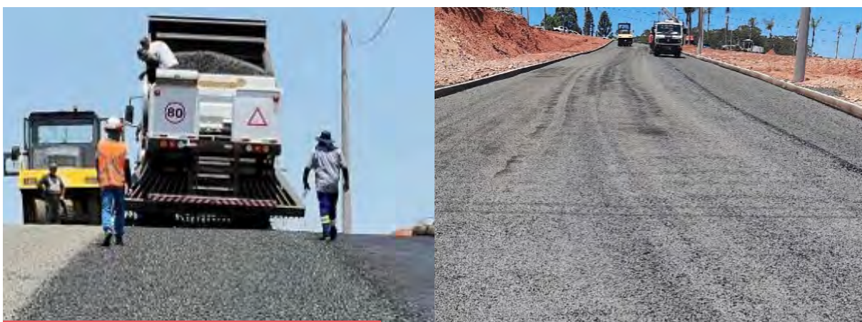
Figura 42. Execução de TSD com multidistribuidor
