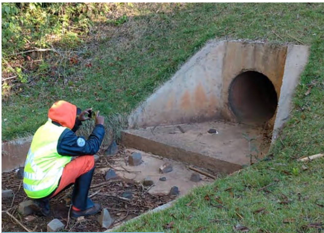
Figura 23. Inspeção de drenagem
