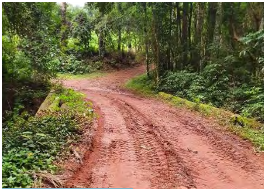
Figura 8. Seção Transversal sem abaulamento
