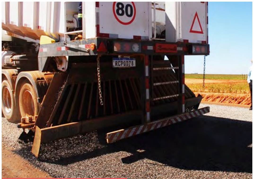
Figura 40. Execução de TSD na Bahia
