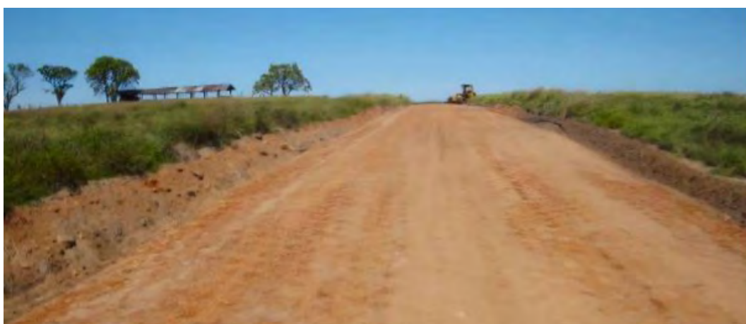
Figura 32. Mistura de argila laterítica com brita em trechos experimentais
