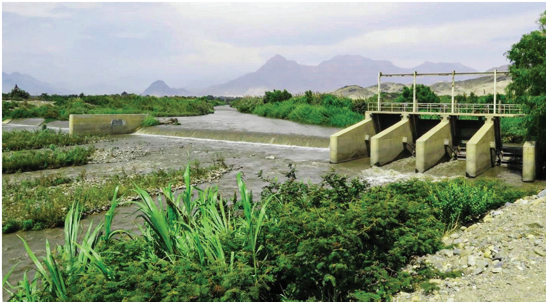
Fotografía 2-1. Presa y bocatoma del río Moche, diciembre 2019.
